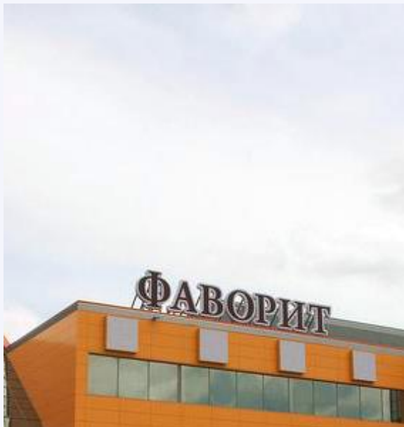
ТРЦ «Фаворит» Строительство ТРЦ в г. Тюмень.
