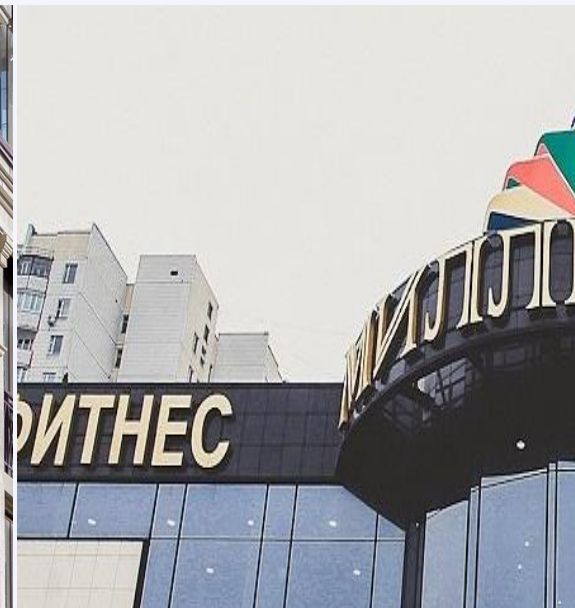
Миллениум Переделка здания универмага в фитнес-клуб
